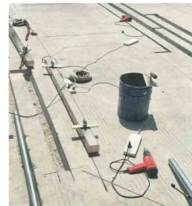
宁波奉化项目现场
