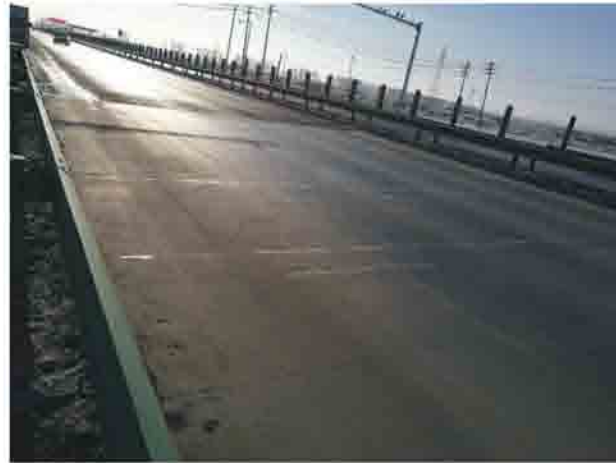
辽宁德惠项目现场
