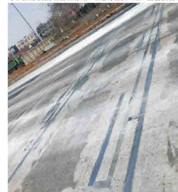
山东滕州项目现场
